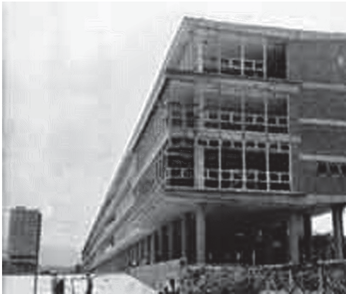
Estructura del edificio que albergó inicialmente a la Facultad de Derecho (primer plano) y a la de Filosofía y Letras (al fondo).
